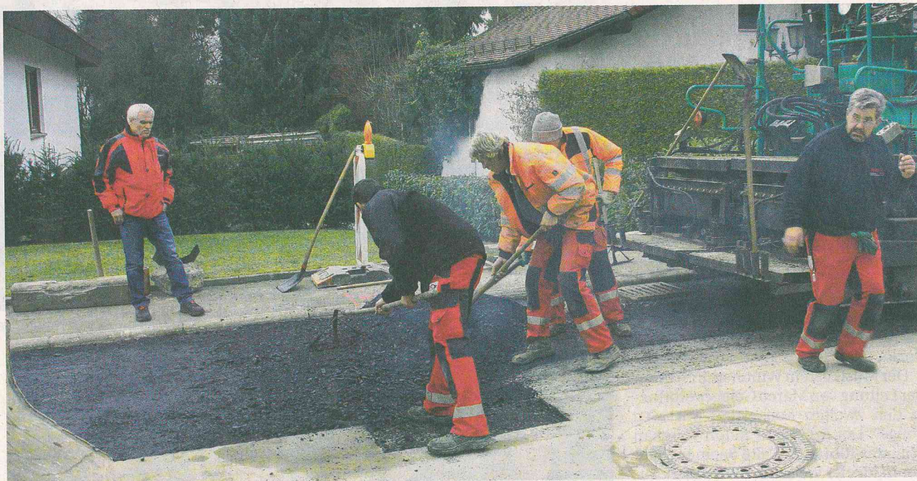
Die Tiefbauarbeiten im Seebacherweg in der Stockacher Nordstadt werden diese Woche abgeschlossen, dann ist der Hochwasserschutz dort komplett. Im Bild links Reiner Müller vom Stadtbauamt Stockach. BILD: BEC
